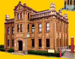
旧サッポロビール九州工場
