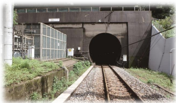
【関門隧道】＊隧道＝トンネル
